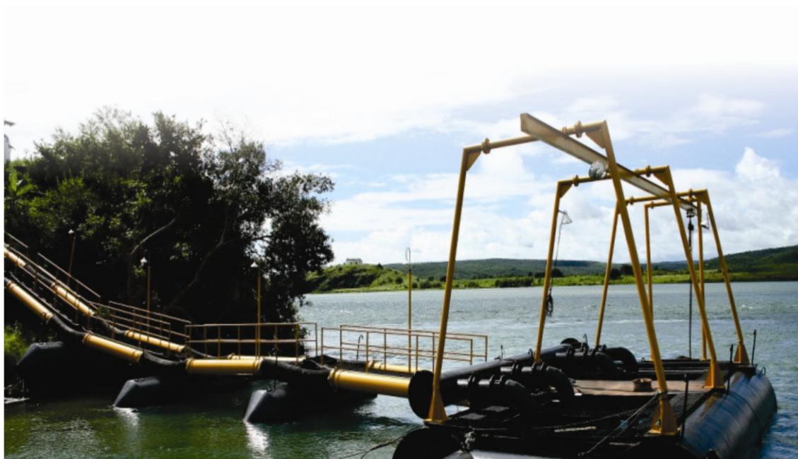
Foto - Aspecto da obra do Sistemas de Adutoras
