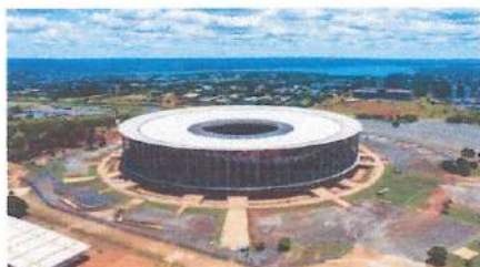
Arena BRB Mané Garrincha, em Brasília, deve receber cerca de 10 mil visitantes por dia / Foto: Divulgação
